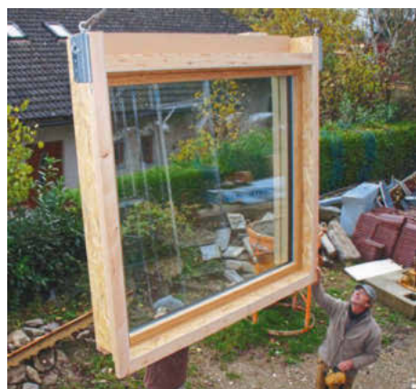
/ Vorfertigung ist Trumpf: Das Fenster wird immer als Einheit mit der Laibung produziert.
